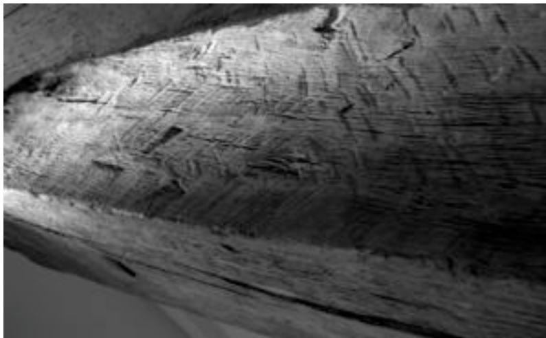
Bild 20. Ektimmer fällt 979-980. Med tydliga spår efter sprättäljning. Foto Karl-Magnus Melin.
