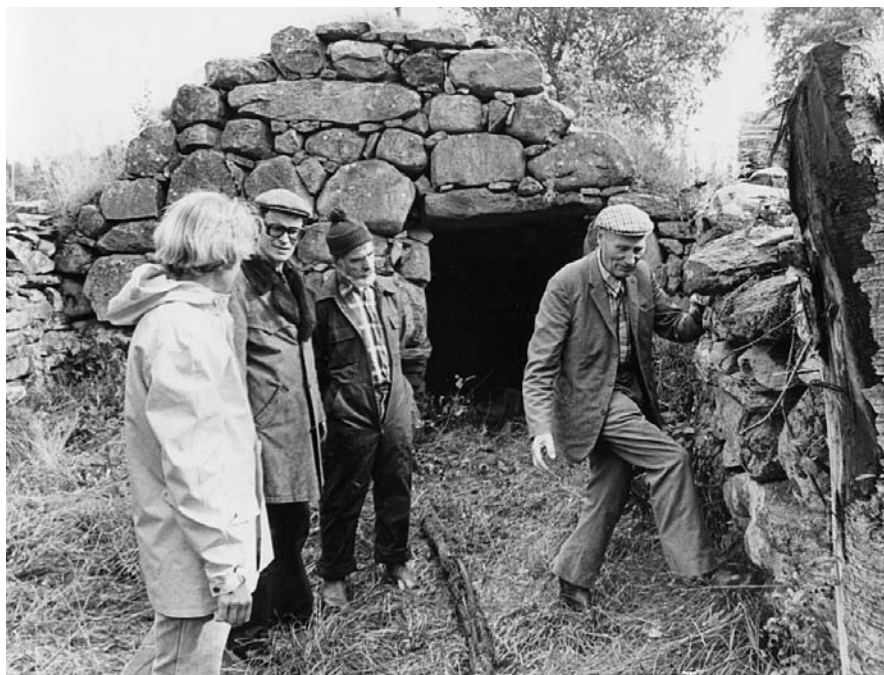
Start på renoveringen i N Hultseröd. Stenhuggarmästare John Roth från Härsnäs inspekterar sidoväggarna i "brytrummet". Foto: Bert Hagström
