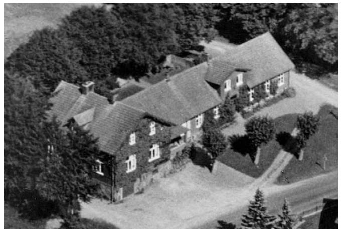
Skolbyggnaden från mitten av 1930-talet. Äldsta delen uppfördes 1856. 1903 förlängdes den 2,5 meter åt öster och 1908 tillkom flygeln åt väster. Nya skolan blev färdig först 1939.
