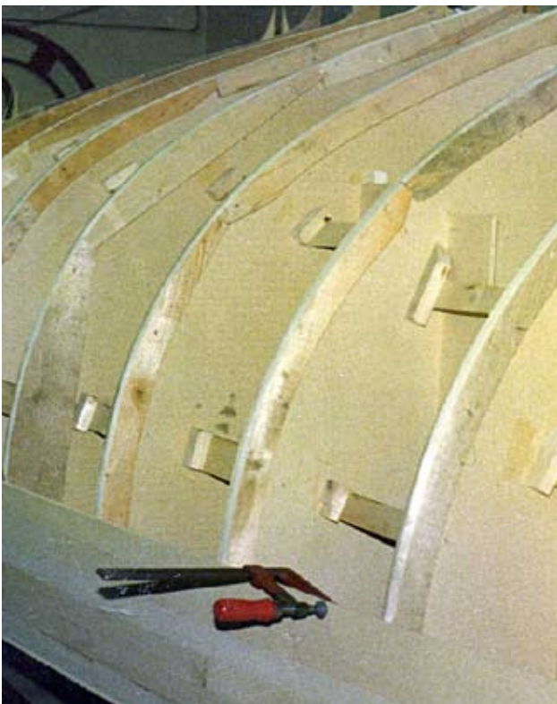
Bilden visar de utsågade spanten, som försetts med pålimmade träförstärkningar vid konturen, för att vi skulle ha något att spika fast bordläggningen i.
