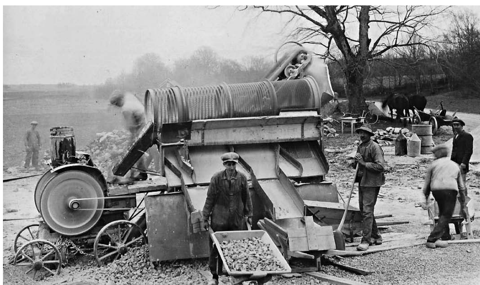
Arbetet i full gång och lägg märke till hur man med en enkel anordning sorterade den krossade stenen i fyra olika storlekar. Man krossade några veckor på hösten när betorna var levererade och före arbete i bokskogen. Det påbörjades med att utvalda träd så småningom blev ved för att ge värme. Lagg märke till det lilla vita bordet vid trädet, där hade August J. sin kontorsplats och bokförde noga varje gårds tilldelning oavsett hur mycket sten man bidrogit med.
